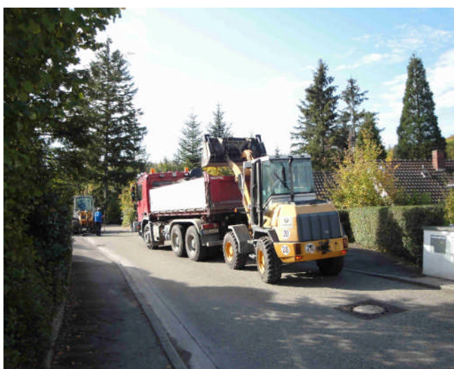
Gehweg Sanierung "Hinter Lehen"
